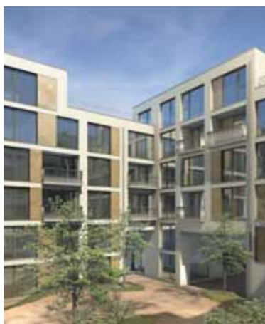
Hotterstraße: moderne Fassaden zum grünen ruhigen Innenhof
