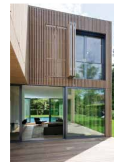
Blick aus dem Patio in den Wohnraum
