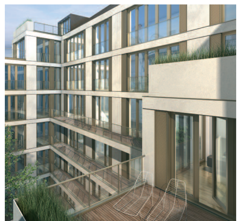
Blick auf die Innenhoffassade
